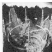
500米口径球面射电望远镜环聚合龙图
